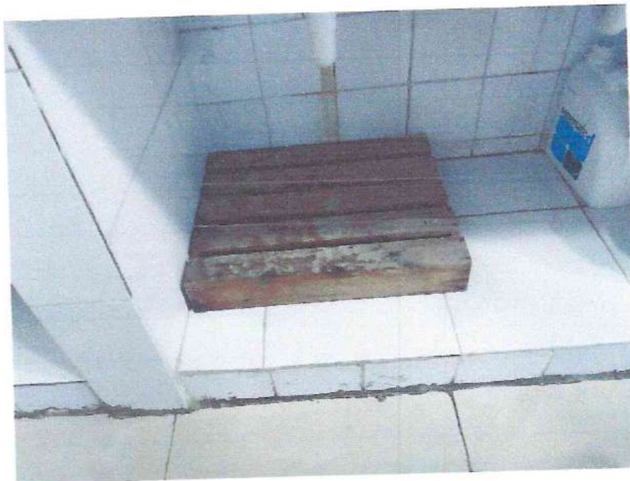
Foto 46. Se aprecian los muebles de concretos revestidos con mayólica en estado de deterioro las juntas manchadas y las mayólicas deterioradas.
