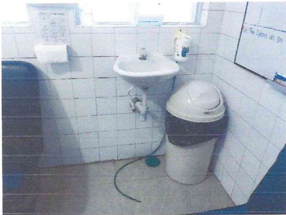
Foto 18. Se puede apreciar el lavatorio en mal estado, mayólicas del zócalo desgastadas, no hay zócalos sanitarios.
