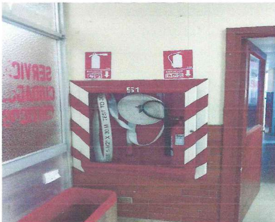
Foto 36. Se puede apreciar el gabinete del sistema contra incendio, inservible.
