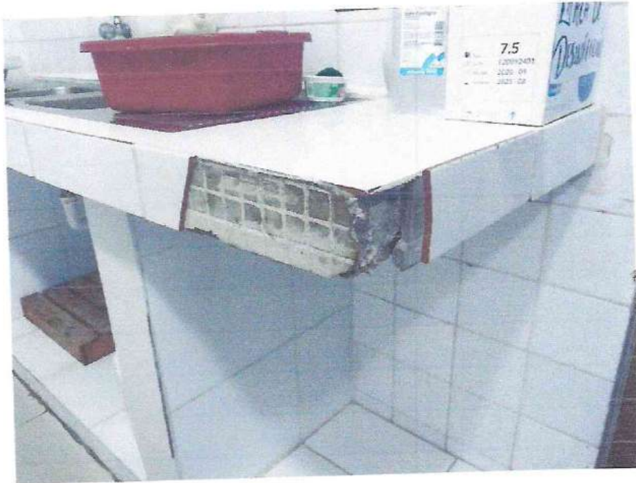
Foto 46. Se aprecian los muebles de concretos revestidos con mayólica en estado de deterioro las juntas manchadas y las mayólicas deterioradas.
