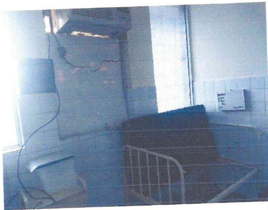
Foto 26. Se puede observar el área de hospitalización de niños, las mayólicas de los zócalos desgastados, puertas deterioradas, ventanas de vidrios y en estado de desuso.
