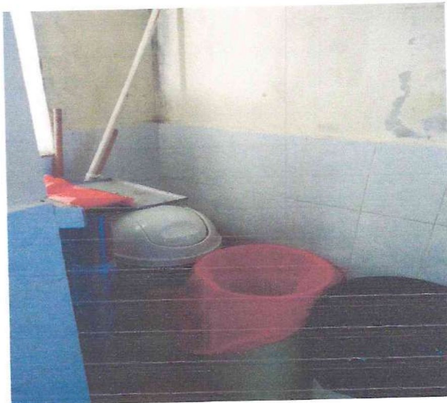
Foto 50. Se puede observar los tacho de basura en el área de lavadero, los muros manchados de humedad y las mayólicas deterioradas, los pisos desgastados.
