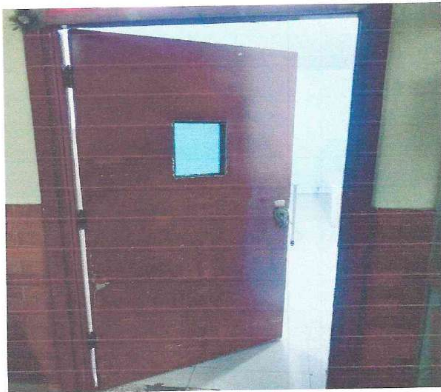
Foto 40. Se puede apreciar la puerta de ingreso al baño de desinfección deteriorada y apollillada, las mayólicas rotas de los zócalos.
