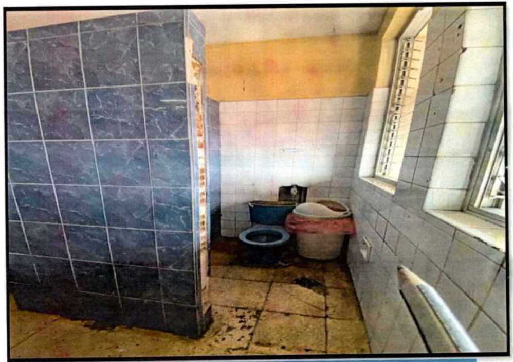
FOTO N°04: LOS ZOCALOS DE LOS SERVICIOS HIGIENICOS NECESITAN SER REPLAZADOS POR UNOS ZOCALOS NUEVOS, POR TEMA HIGIENICO DE LOS PACIENTES Y PERSONAL DE SERVICIO DE SALUD.
