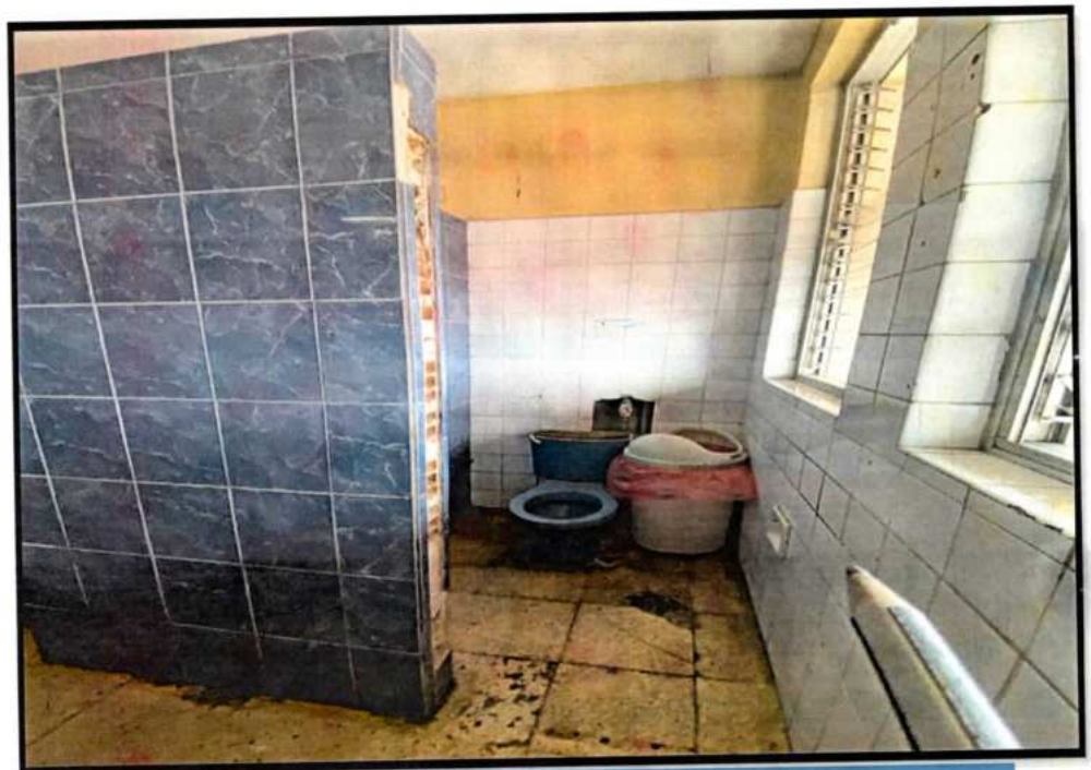
FOTO N°04: LOS ZOCALOS DE LOS SERVICIOS HIGIENICOS NECESITAN SER REMPLAZADOS POR UNOS ZOCALOS NUEVOS, POR TEMA HIGIENICO DE LOS PACIENTES Y PERSONAL DE SERVICIO DE SALUD.
